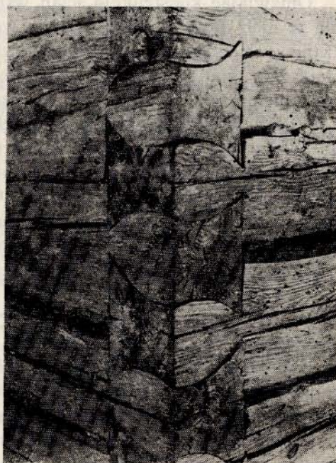
Ryc. 39. Zawęglowanie na rybi ogon z owalnymi zacięciami. Wieś Gawie- niańce pow. Sejny
