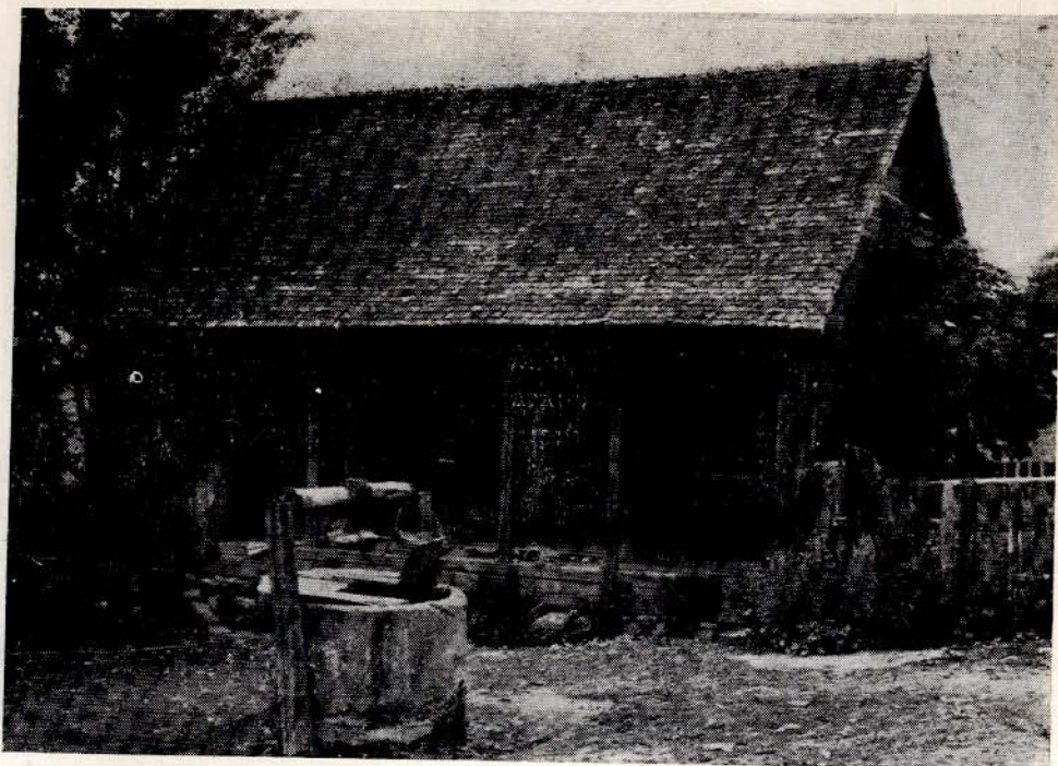
Ryc. 37. Spichrz dwukomorowy, szerokofrontowy z podcieniem. Wieś Posejny pow. Sejny
