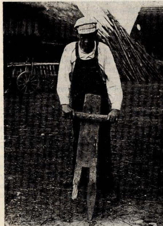
Ryc. 4. Fragment sochy łopatkowej (rozdwojona część pracująca bez ołobli, sośników i łopatek) pozostawionej przez starobrzędowców we wsi Pogorzelce pow. Sejny
