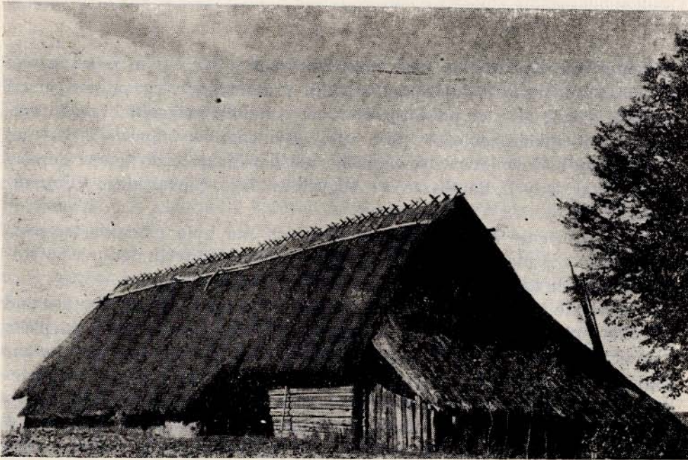
Ryc. 28. Stodoła zrębowa z plewnikiem. Wieś Żwikielel pow. Sejny
