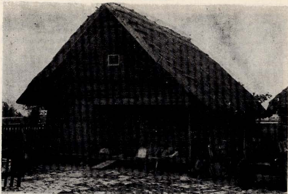
Ryc. 33 Spichrz wąskofrontowy, z częściowo zabudowanym podcieniem. Wieś Wójtokiemie pow. Sejny
