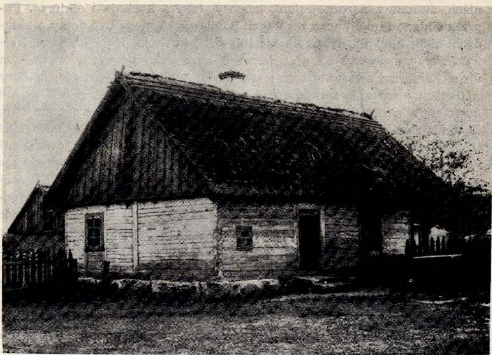
Ryc. 27. Dom szerokofrontowy asymetryczny (z sienią, izbą, kuchnią i alkierzem). Wieś Posejny pow. Sejny
