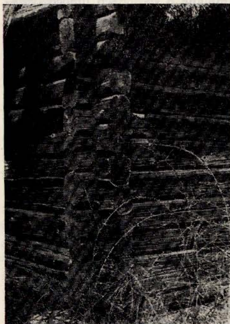
Ryc. 38. Wiązanie zrębu na obłab. Wieś Podgawieniańce pow. Sejny
