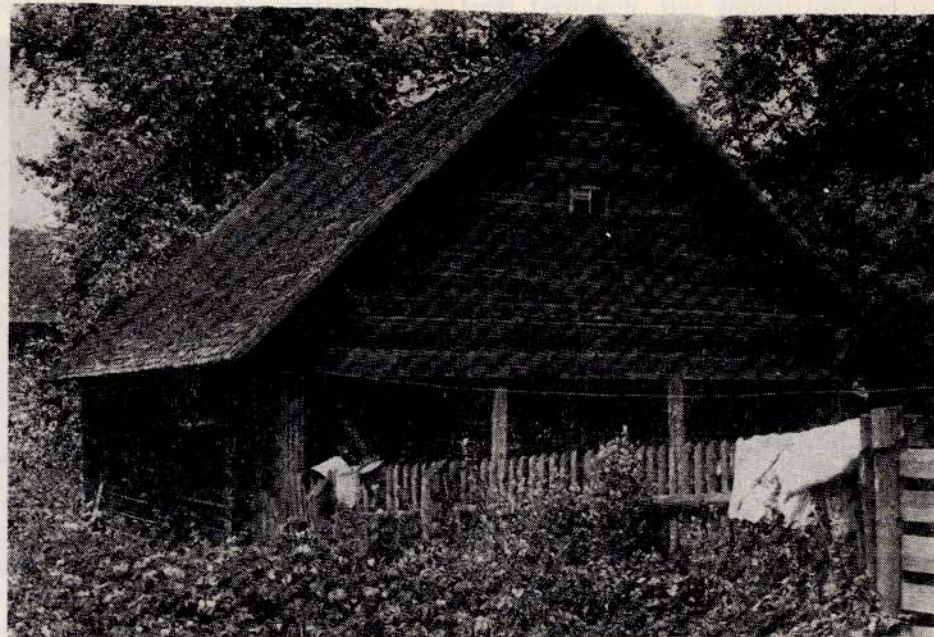
Ryc. 34. Spichrz zrębowy wąskofrontowy z podcieniem. Wieś Gawieniańce pow. Sejny
