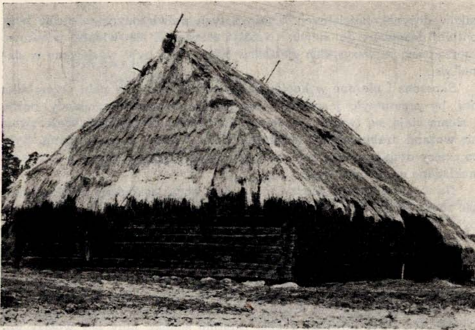
Ryc. 10. Stodoła zrębowa jednoklepiskowa z XIX w. Wieś Gawieniańce pow. Sejny
