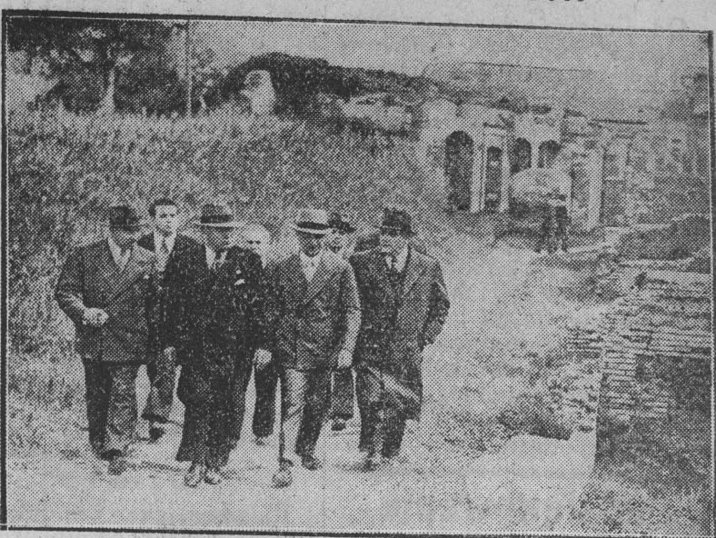
Mussolini (w środku w ubraniu cywilnym) ogląda prace wykopaliskowe, prowadzone od szeregu miesięcy na terenie Ostii pod Rzymem
