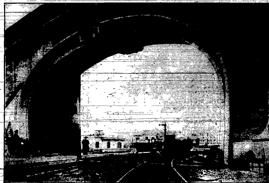
Układanie szyn linii kolejowej w siedzibie Ojca Świętego — Watykanie.
