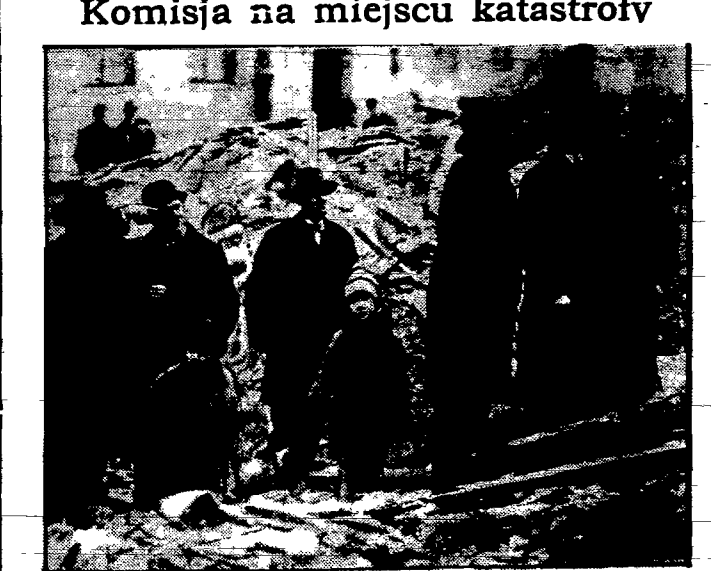
Badanie przyczyn katastrofy przy ul. Krochmalnej w Warszawie przez komisję sądowno-śledczą, złożoną z przedstawicieli władz sądowych, miejskich, wojskowych i Stowarzyszenia Architektów.
