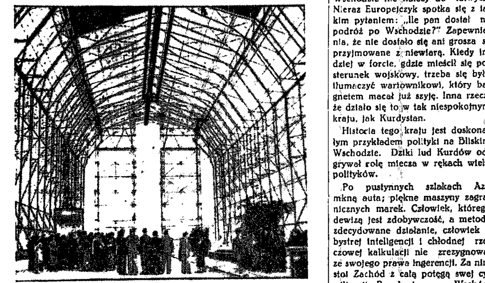
W porcie lotniczym Rio de Janeiro Santa Cruz wybudowano specjalną halę, w której znajdują pomieszczenie sterowców.
