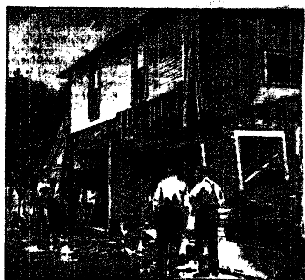
Wielkie uszkodzenia przewodów gazowych wywołał w powietrzu gwałtowny wybuch w Barberton (Ohio). Szczęśliwym okolicznością katastrofa nie pociągnęła za sobą ofiar w ludziach.
