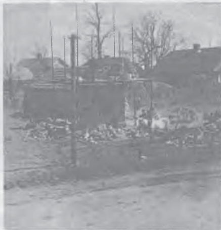
Budowa transformatora na placu cerkiewnym w Brańsku, 1942 r.
