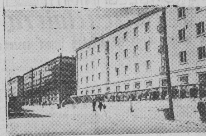
Budynki ZOR-owskie przy ulicy 1 Maja przywdziałają jaśnową szatę. W jasnym kolorze otynkowany został pierwszy, a robotnicy przystępują do tynkowania następnego. NA ZDJĘCIU: uspaniale wyglądający w białej szacie budynek ZOR przy ulicy 1 Maja. Fot. „Gazeta” — A. Bor.
