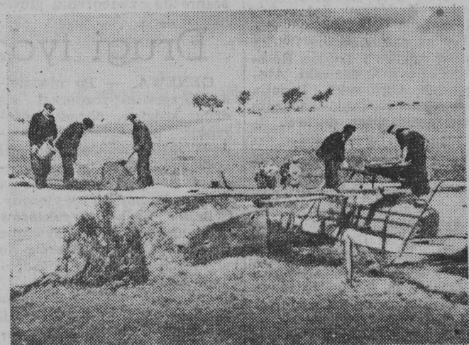
Chłopi ze wsi Modzele-Stare, gromada Wygoda, w pow. zambruskim przystąpili do budowy mostku na drodze prowadzącej do ich wsi.
