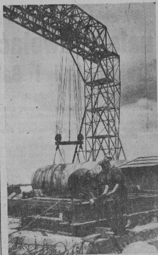
Na Lubelszczyźnie, obok nowoczesnej cementowni Rejowiec II, powstaje nowy obiekt — cementownia Rejowiec III. NA ZDJĘCIU: monterzy Władysław Jakubowicz i Wacław Adamczuk przy montażu podstawy pod piec obrotowy cementowni. CAF — fot. Szyperko
