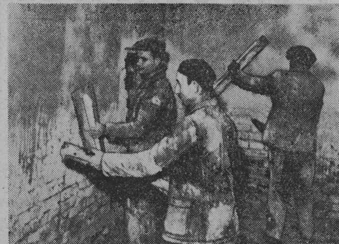
NA ZDJĘCIU: brygada tynkarska Władysława Surowca z budowy nr 151 w Białymstoku na wacie październikowej. Członkowie brygady zobowiązali się wykonywać dziennie zamiast 23 — 25 m kwadratowych tynku.
