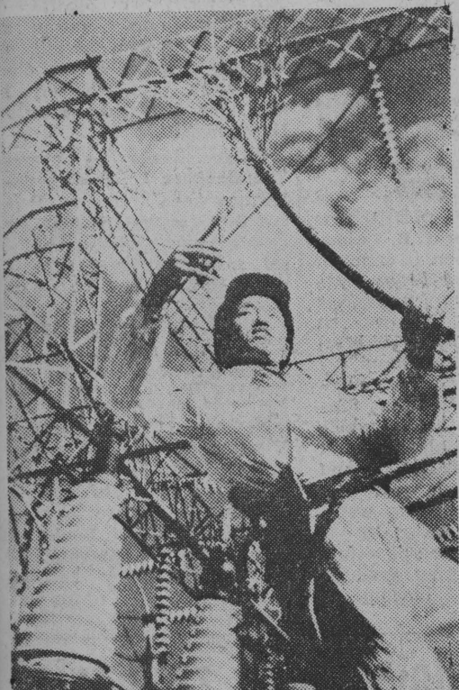
NA ZDJĘCIU: Kim Ir Sen — pracownik elektrowni Džondżin naprawia linie wysokiego napięcia. Fot. — CAF
