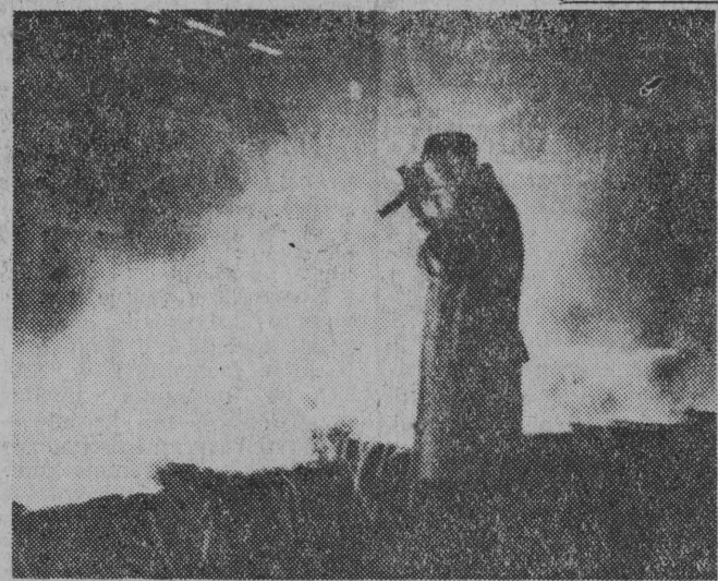
NA ZDJĘCIU: rozlewanie stali do form wlewkowych w Hucie im. Lenina. Kontroler techniczny Franciszek Grudzień sprawdza temperaturę stali.
