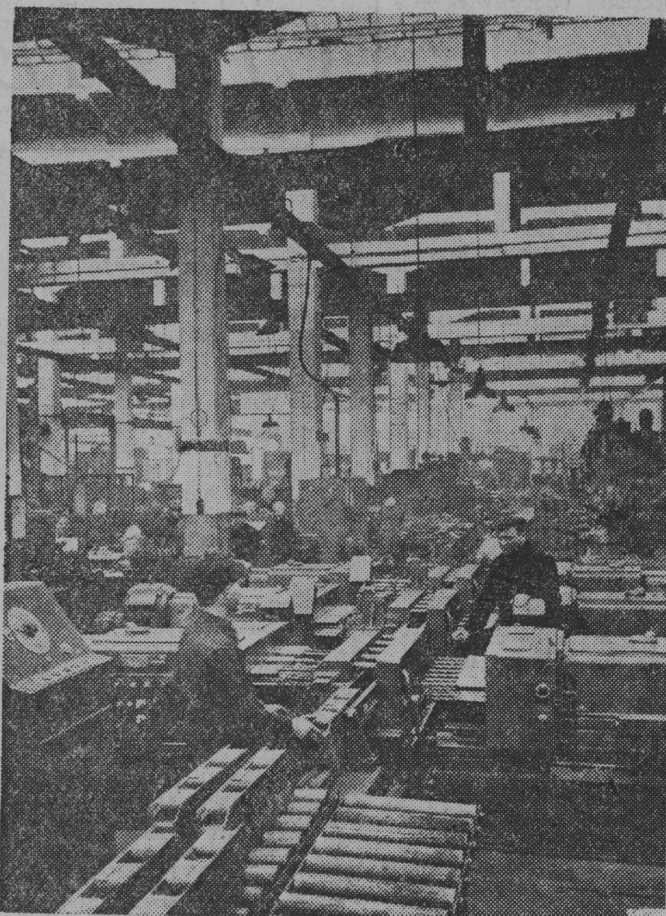
NA ZDJĘCIU: fragment hali obrabiarek w Fabryce Samochodów Ciężarowych w Starachowicach. Tu systemem taśmowym, produkowane są silniki do samochodów „Star”. CAF — fot. Dąbrowski
