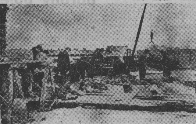
NA ZDJĘCIU: budowa nr 253/254. Fot. „Gazeta”
