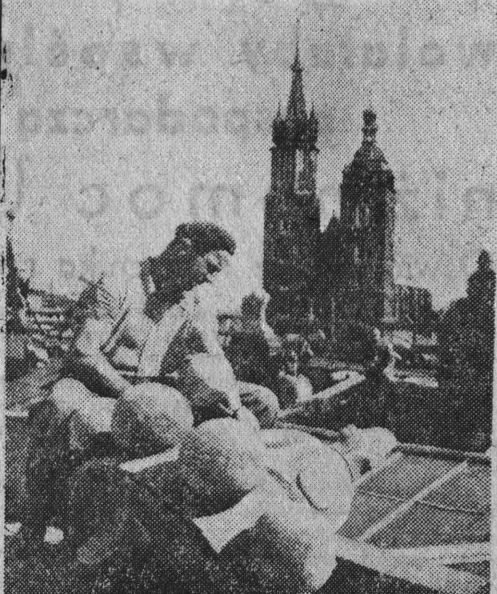
NA ZDJĘCIU: zniszczone rzeźby altarki są uzupełniane przez kamieniarzy Pracowni Konserwacji Zabytków.
