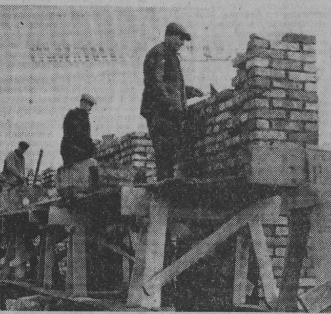
To brigada murarska Piotra Płupa, jedna z prężniejących na budowie.
