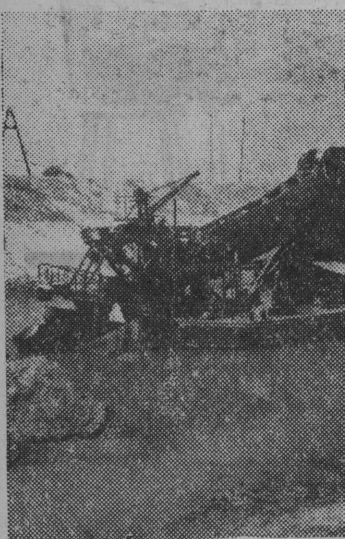
W okolicach Skawiny budowany jest kanał, który biegnąc prosto od zapory w Łączanach skróci drogę dla barek płynących po Wiśle, a zarazem doprowadzi wodę do będącej w budowie elektrowni w Skawinie. NA ZDJĘCIU: przewidywany kanał pracuje nortelarka „Mefisto”.
