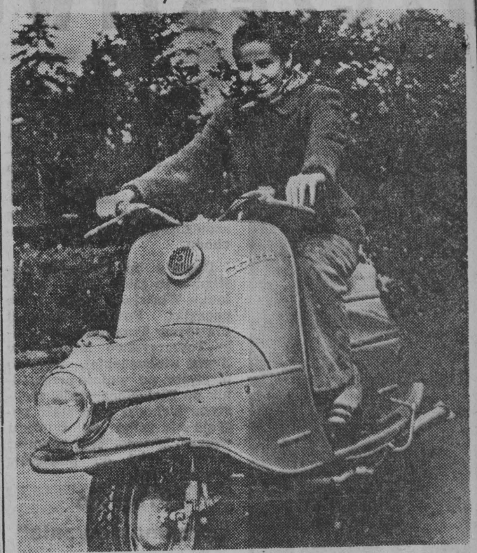
Nowy model skutera czeskosłowackiego o 4 bieгах i mocy silnika 8 HP. Maksymalna szybkość — 85 km/godz., zużycie paliwa do 3 litrów na 100 km.
