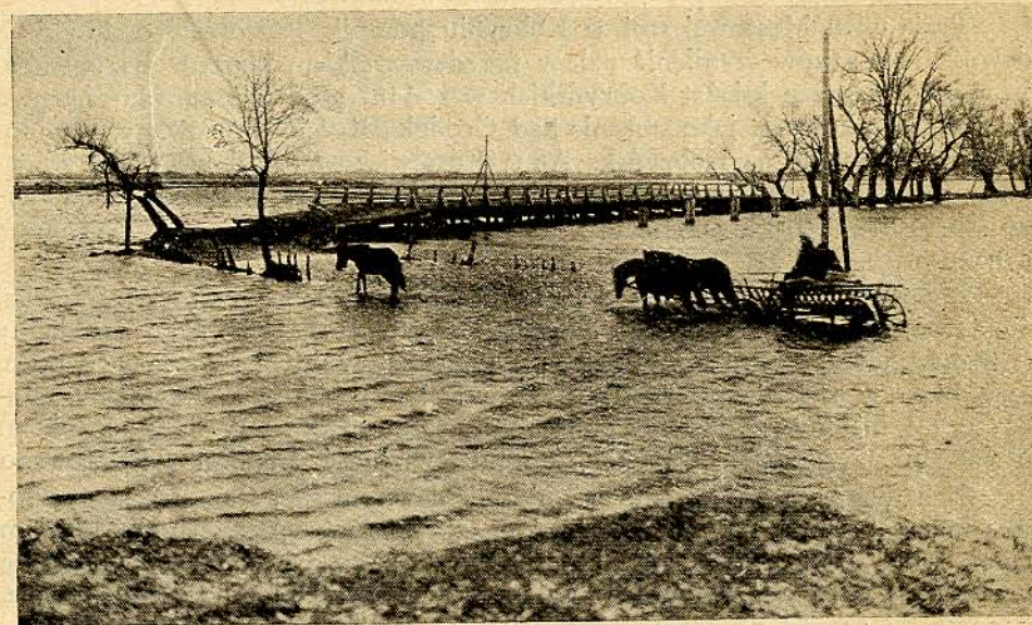
Dojazd do mostu w czasie rozlewu rzeki.
