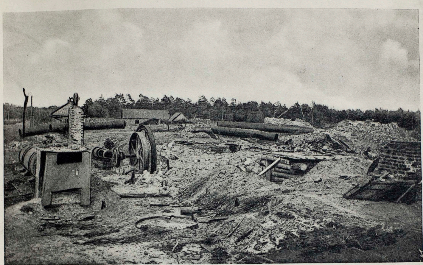
Zerstörte Glasfabrik in T.
