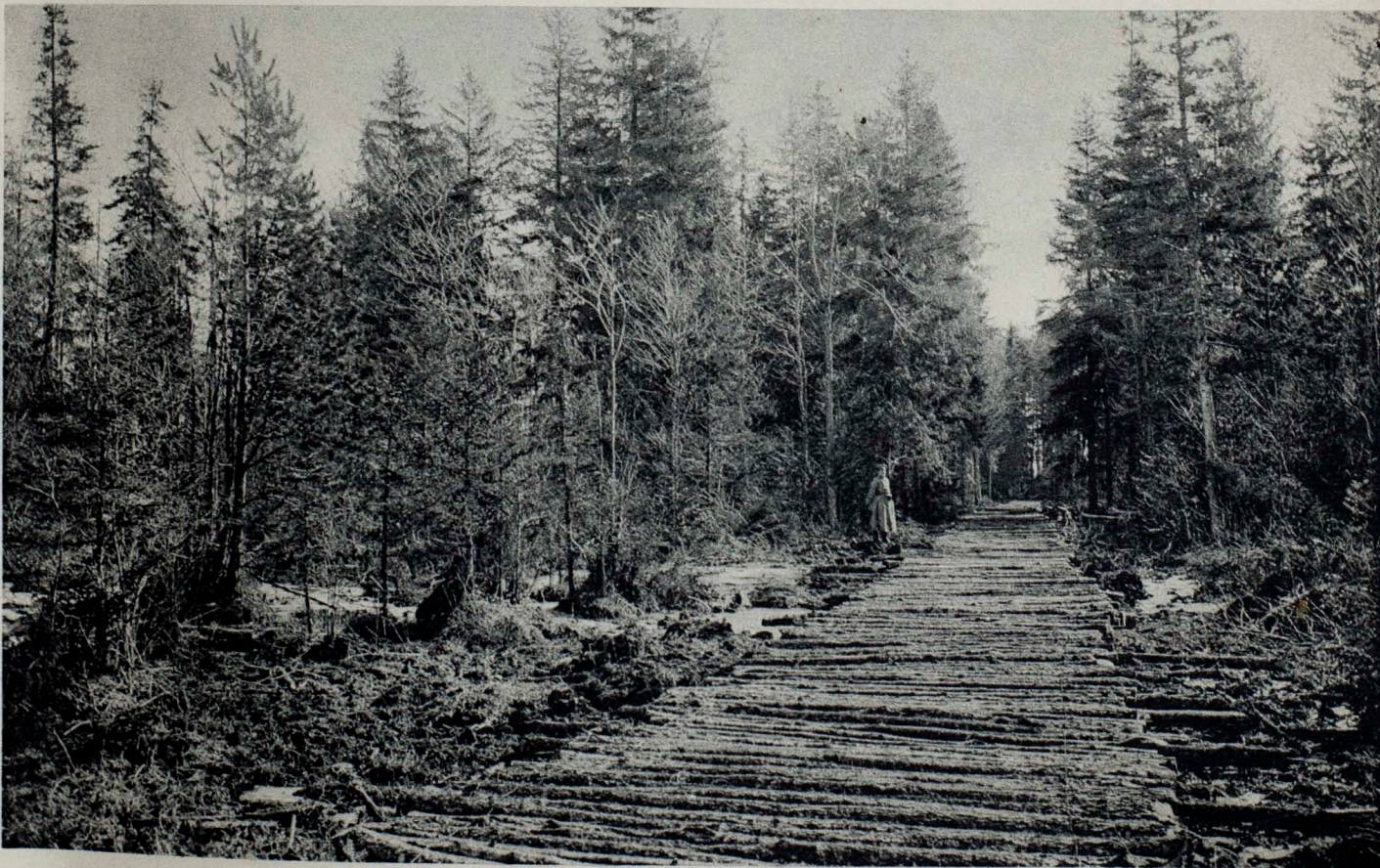
Knüppeldamm durch Sumpfwald.
