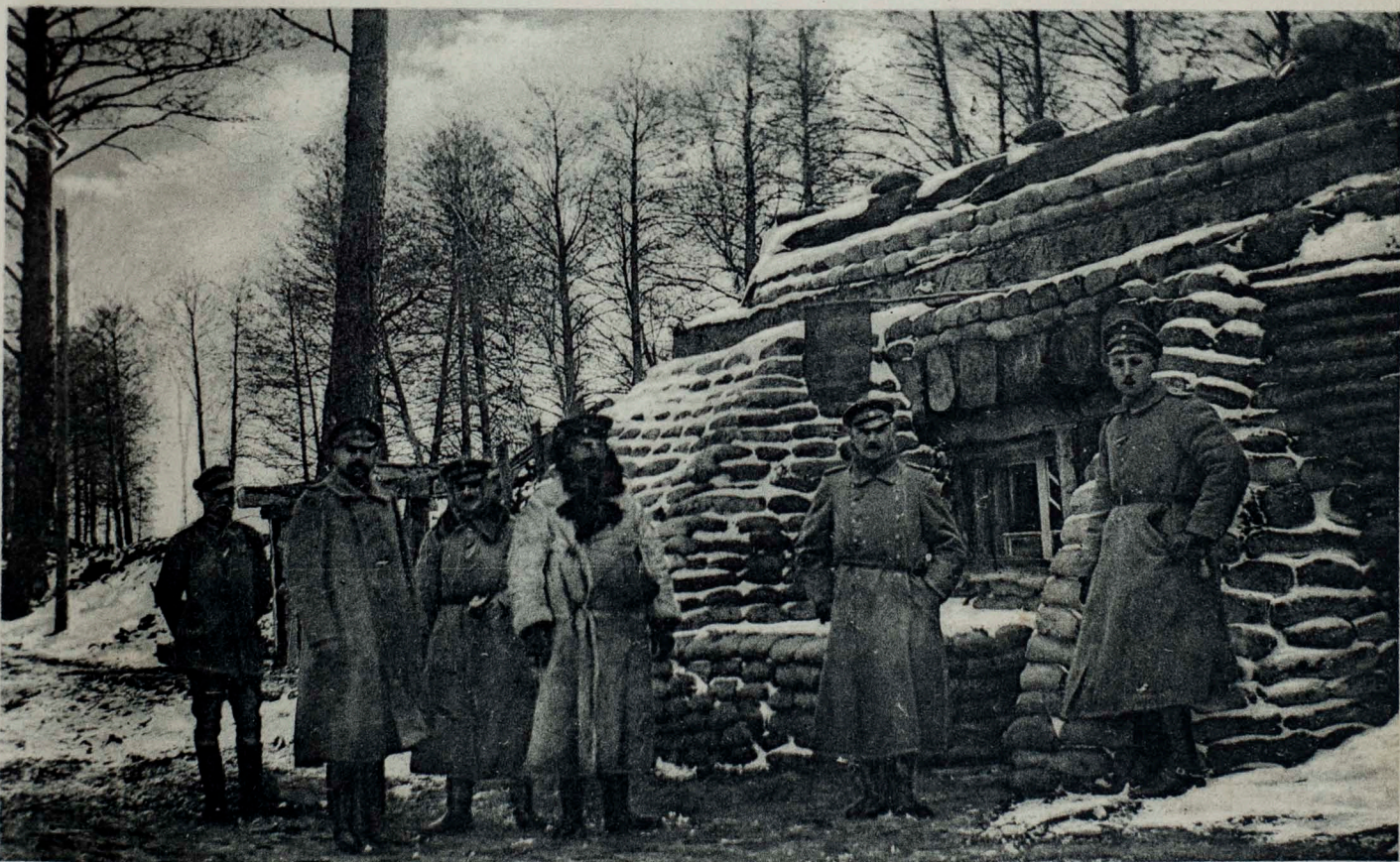
Unterstand am Kanal.
