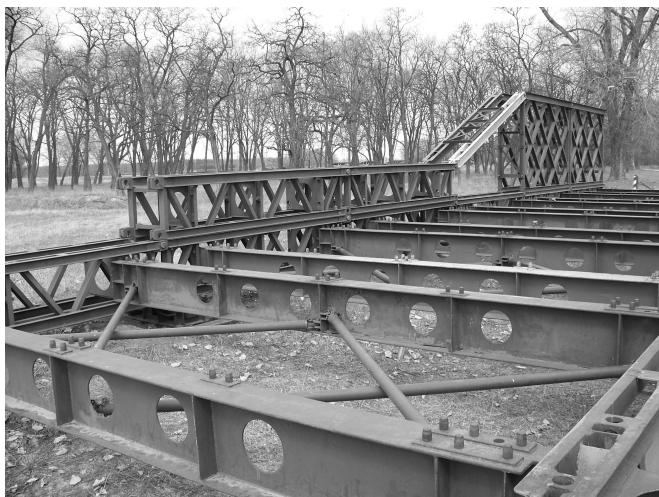
Rys. 1. Widok na most składany typu DMS-65 podczas montażu – połączenie belki poprzecznej z dźwigarami głównymi złożonymi z kratownic przestrzennych (Mondel, 2012)
