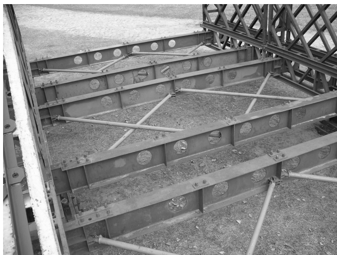
Rys. 1. Widok na most składany typu DMS-65 podczas montażu – połączenie belki poprzecznej z dźwigarami głównymi złożonymi z kratownic przestrzennych (Mondel, 2012)
