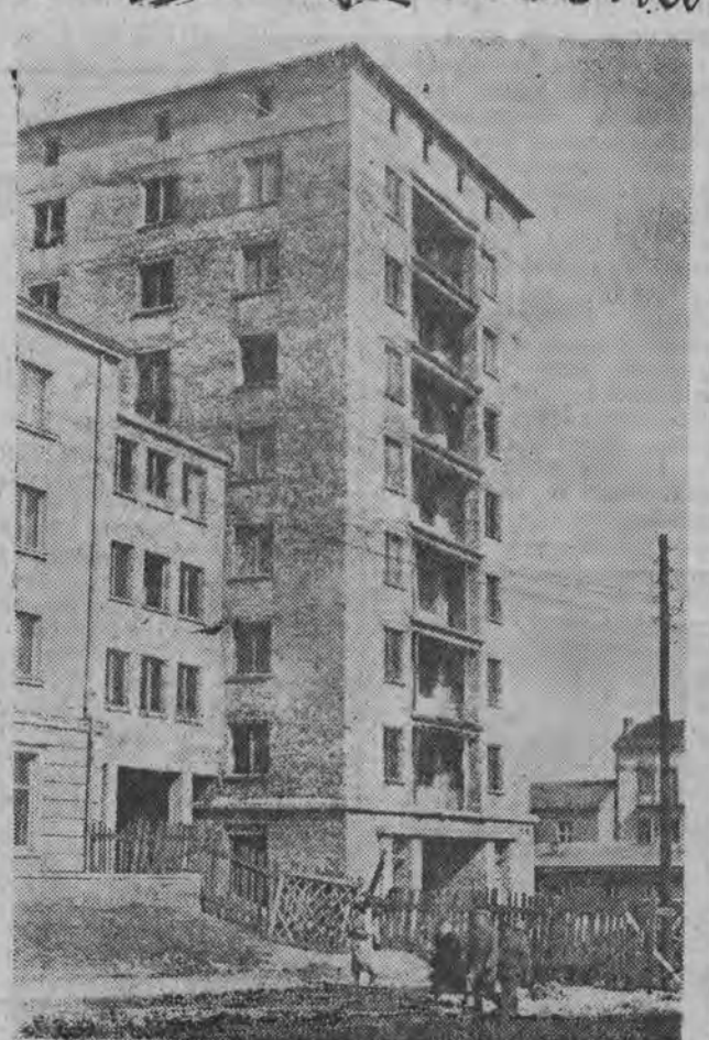
Tylko na pozór wydaje się, że na budowie wieżowca nic się nie dzieje. Wewnątrz trwają intensywne prace wykończeniowe.
