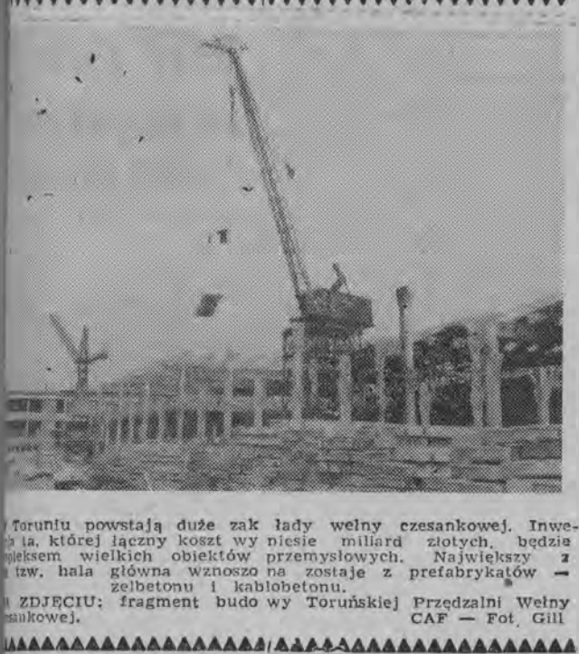
Toruniu powstają duże zakłady welny czesankowej. Inwestycja, której łączny koszt wyniesie miliard złotych, będzie obejmowała wieloletni program budowy. Największy z zakładów, hala główna wznosząca się z prefabrykatów — żelbetonu i kablodetonu.
