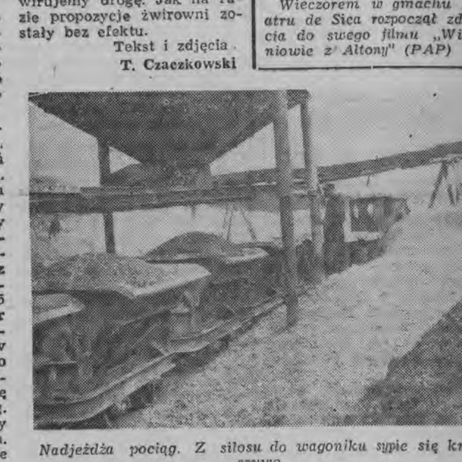
Nadjeżdża pociąg. Z silosu do wagoniku sypie się kruszywo.
