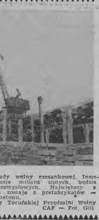
Toruniu powstają duże zakłady welny czesankowej. Inwestycja, której łączny koszt wyniesie miliard złotych, będzie obejmowała wieloletni program budowy. Największy z zakładów, hala główna wznosząca się z prefabrykatów — żelbetonu i kablodetonu.
