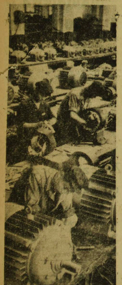
Montaż silników elektrycznych w Fabryce Urządzeń Elektrycznych w Phenianie. CAF
