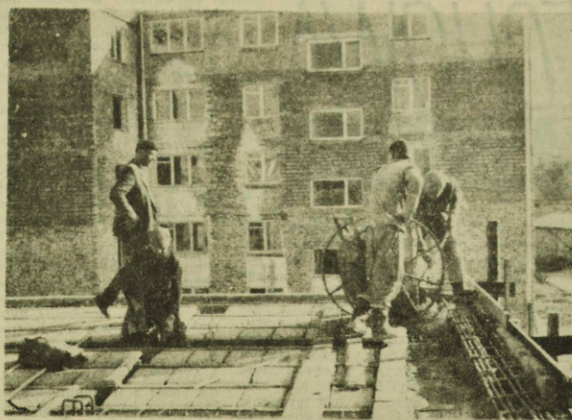
Budowa pawilonu handlowego w osiedlu „Północ II”. Fot. Z. Zaremba
