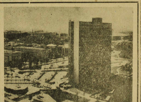
Najnowszy wieżowiec rzymski zbudowany dla koncernu przemysłowego ENI posiada 74 m wysokości, 15 m szerokości, 23 piętra (3 — pod ziemią), a powierzchnia okien wynosi 12.500 m kw. Do konstrukcji nowego wieżowca zużyto 3.000 ton stali. CAF
