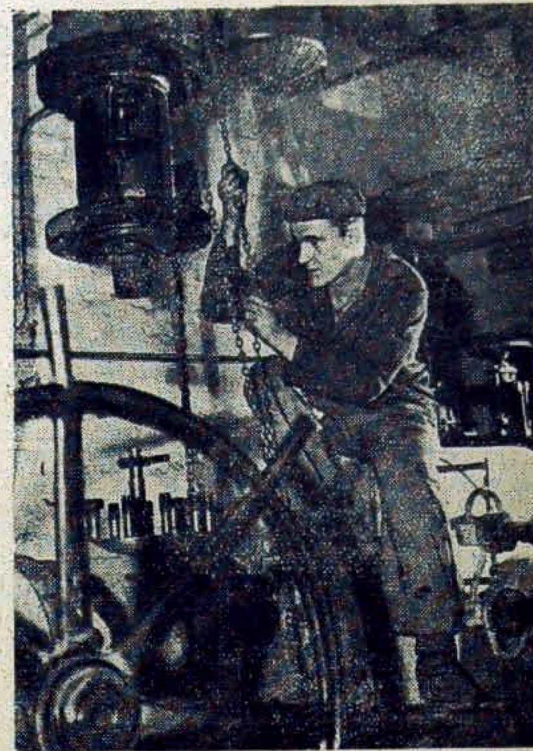
16 września w elektrowni Zabrze uruchomiono nowy kocioł-gigant zaopatrzony w nowoczesne precyzyjne urządzenia automataczne. Jest to jeszcze jedno osiągnięcie naszego 6-letniego planu budownictwa podstaw socjalizmu w kraju. Zabrzeński kocioł jest jednym z największych w Polsce.
