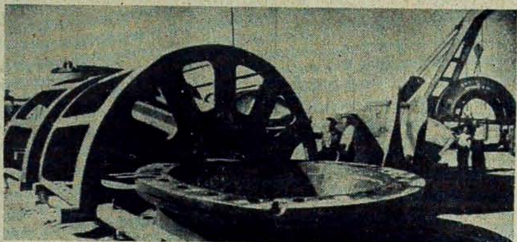
Na plac wyładowkowy cymlańskiej Elektrowni Wodnej codziennie przybywają wagony z urządzeniami dla elektrowni.
