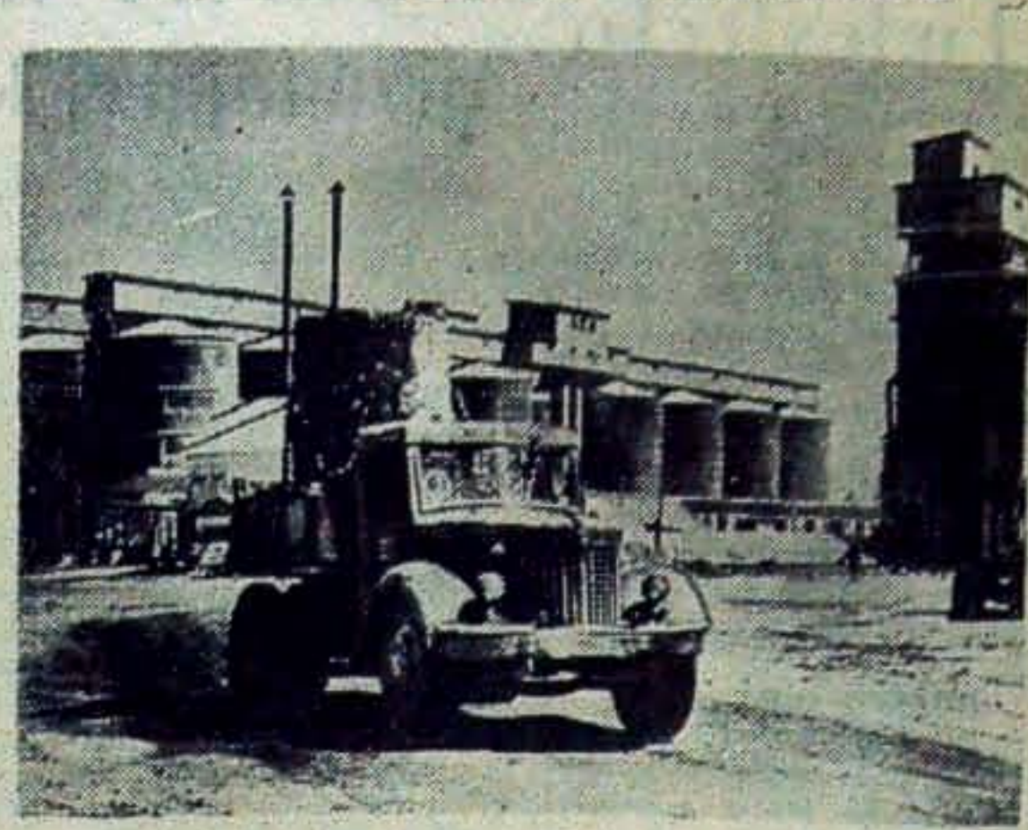
Budowniczości kanalu Wolga-Don zużywają setki tysięcy metrów sześciennych betonu do budowy wielkiej ilości śluz. Na zdjęciu: Jeden z zakładów przemysłowych, w których przygotowuje się beton do budowy śluz. fot. CAP.
