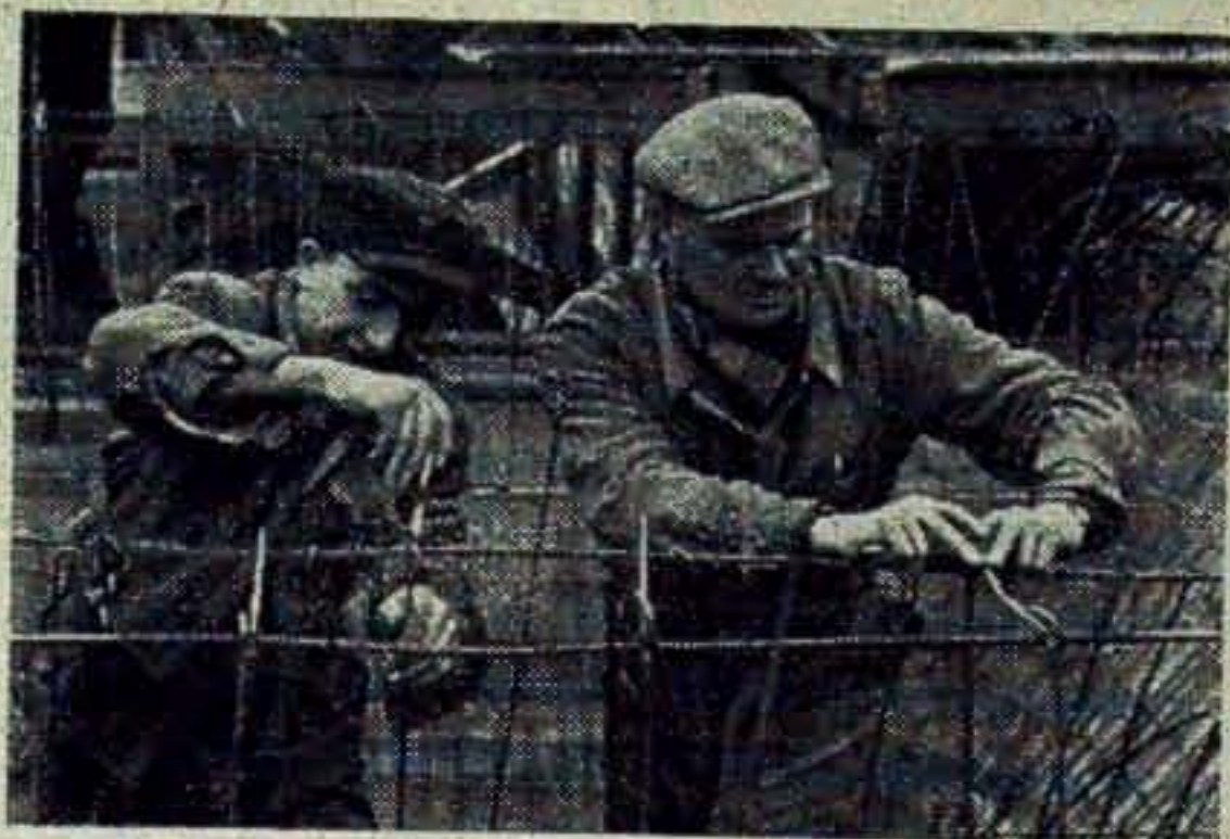
W ramach rozbudowy przemysłu, w Ozorkowskich Zakładach Przemysłu Bawełnianego buduje się nową wielką wykończalnię i elektrownię zakładową.
