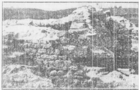
Fragment ruiny zamku Dąbrowki na Ostrowie Lednickim
