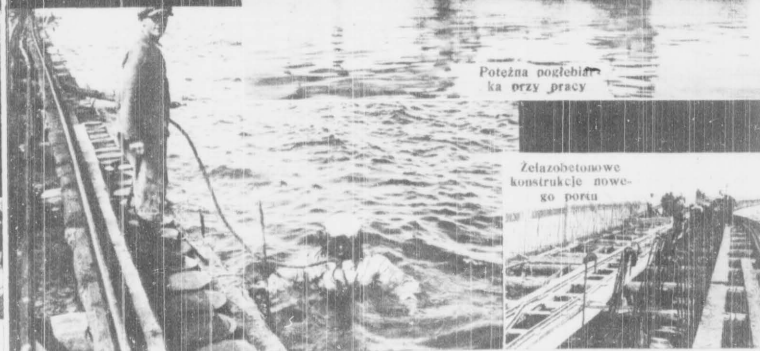
Nurkowie wzmacniają głazami drewniane molo portu
