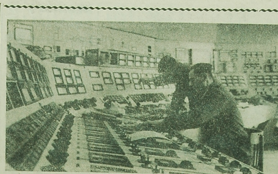
Nasze nowe zakłady energetyczne otrzymują najnowocześniejsze wyposażenie. NA ZDJĘCIU: tak wyglądają urządzenia sterownicze nowej elektrowni.
