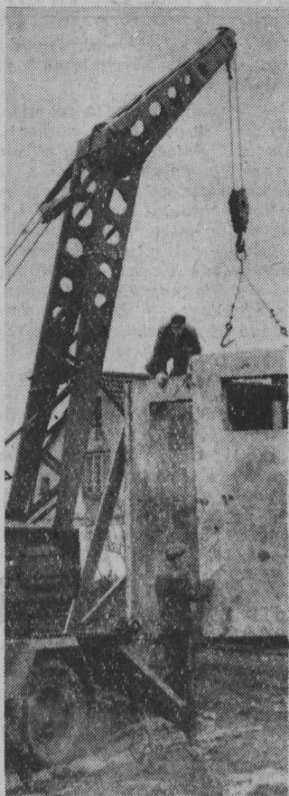
W wielu białostockich wsiach buduje się nowe sklepy z elementów prefabrykowanych. Na zdjęciu budowa sklepu wiejskiego w Jeżewie.
