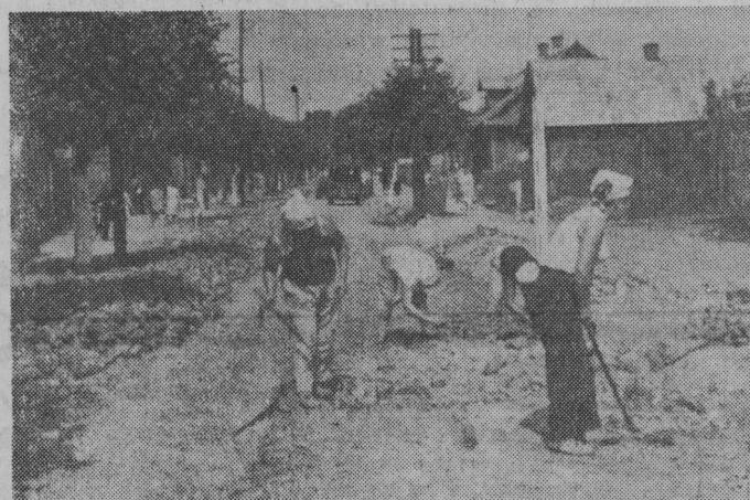
W szybkim tempie trwają prace przy przebudowie ulicy Waryńskiego.
