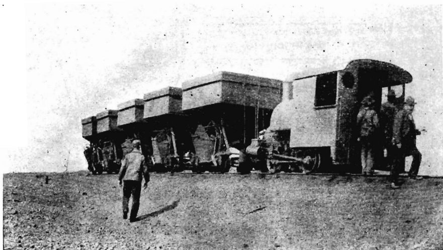
Rys. 104. Pociąg z wagonami do ładowania pieców ulowych w Pensylwanji.
