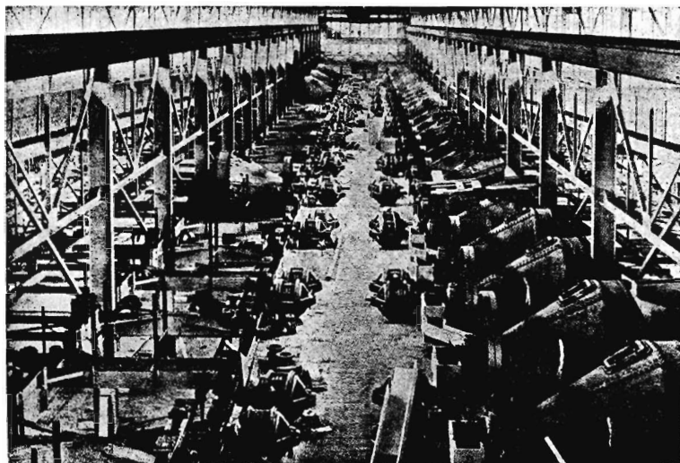
Rys. 250. Rząd młynów kulowych Hardinge'a z oddzielnymi silnikami (w czasie montowania) na kopalni miedzi Calumet & Hecla Co na Jeziorze Górnym St. Zj. Am. Półn.
