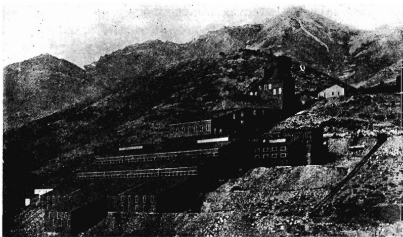
Rys. 161. Zakład wzbogacania rud złota Mercure Mine, w stanie Utah, Am. Półn.
