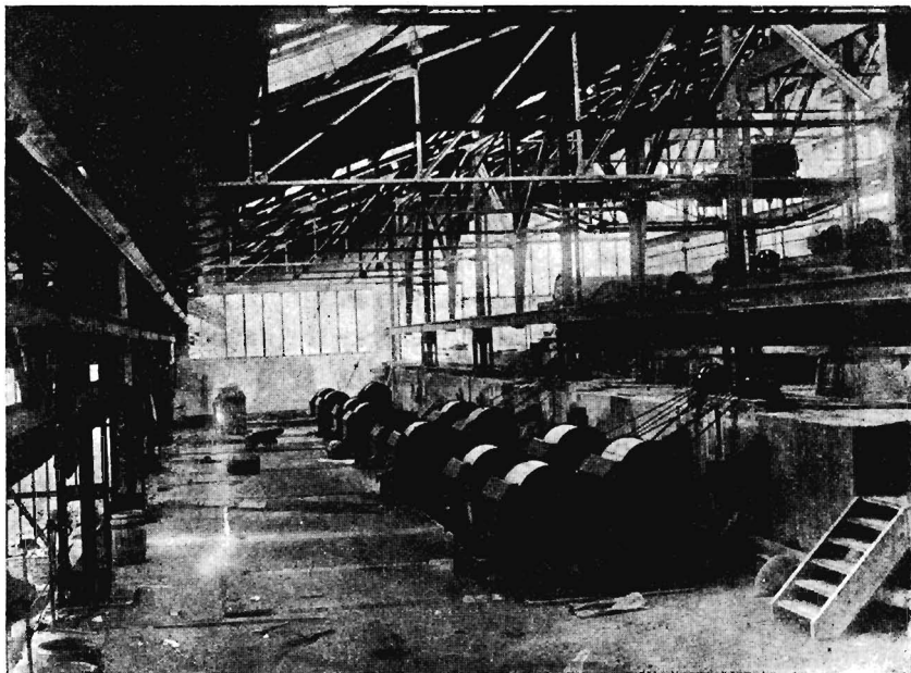
Rys. 249. Widok wewnętrzny zakładu wzbogacania rudy żelaznej sposobem magnetycznym w Süd-Waranger. Rząd podwójnych separatorów Gröndala z oddzielnymi silnikami (w czasie montowania) (II stadjum), ustawionych na występie, leżącym poniżej przedstawionego na rys. 248 występu z młynami rurowymi.
