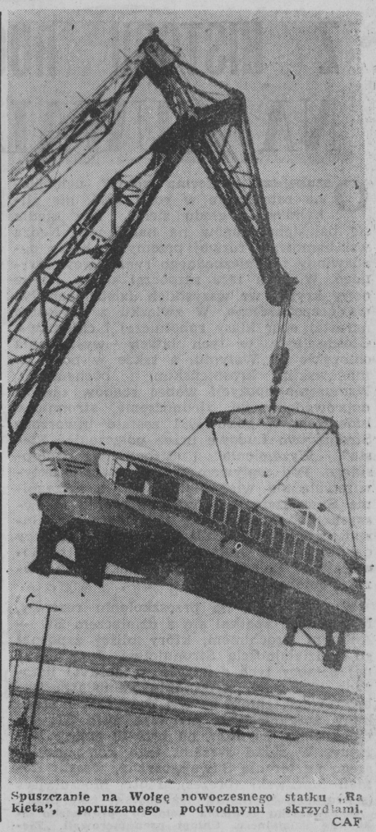
Spuszczanie na Woltę nowoczesnego statku „Raikira”, poruszającego podwodnymi skrzydłami CAF.
