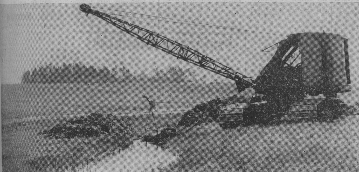
Prace melioracyjne w pow. oleckim
