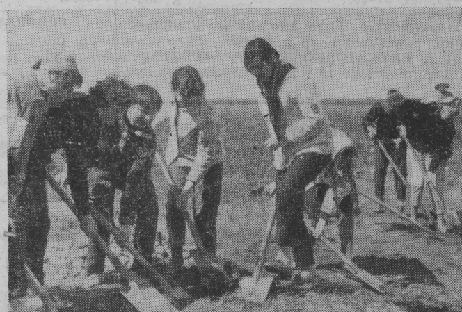
NA ZDJĘCIU: młodzież szkolna pracuje przy niwelacji nawierzchni drogi. Tekst i zdjęcie M. TARASIEWICZ
