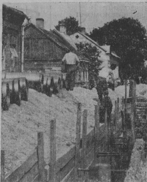
W Suwałkach przeprowadza się obecnie roboty kanalizacyjne. Na naszym zdjęciu: fragment robot przy ul. Armii Czerwonej. Fot. L. Sójkowski
