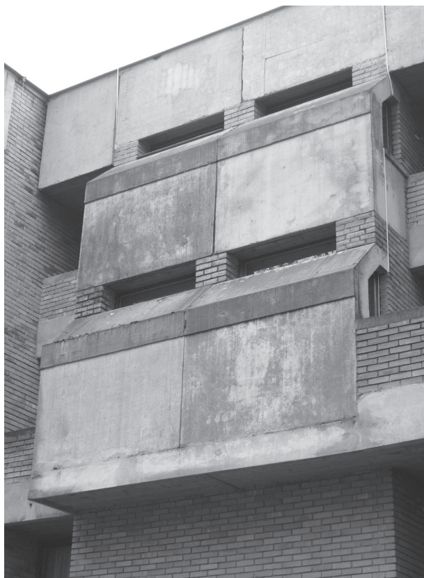
Ryc. 17. Kolegium Polonijne UJ – żelbetowe wykusze. Fot. autor
