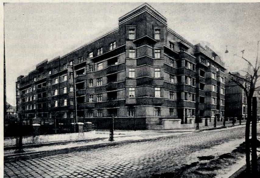
Domy mieszkalne w Chorzowie przy ul. Krzyżowej, zbudowane w latach 1931—32 przez Zakład Ub. na wyp. inw. w Król. Hucie
