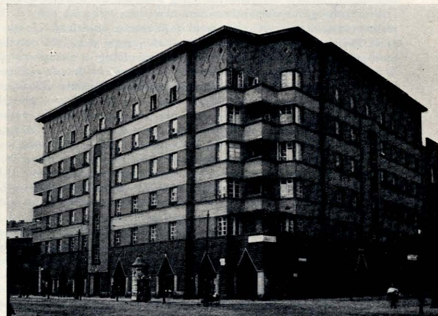
Dom mieszkalny w Krakowie przy ul. Wybickiego, zbudowany w latach 1927—29 przez Z. U. P. U. we Lwowie.
