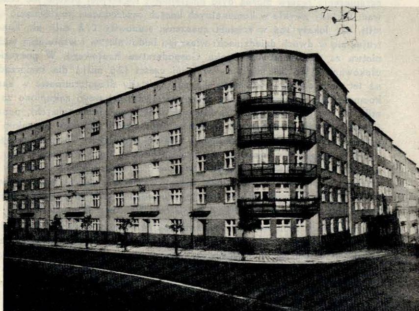
Domy mieszkalne w Katowicach przy ul. Poniatowskiego, zbudowane w latach 1931—32 przez Z. U. P. U. w Król. Hucie
