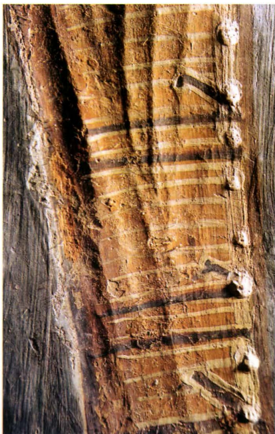
6. Fragment (noga lewa) świętego rycerza z niezidentyfikowanego miejsca filara (pld.?) cerkwi – powierzchnia intonaco po wygładzeniu narzędziem (kość, łopatka metalowa) dającym w tynku łukowate wgłębienia, widoczne tylko w bocznym oświetleniu. Fragment (left leg) of a holy knight from an unidentified part of the pillar (southern?) in the former Basilian church – the intonaco surface after being levelled with a tool (bone, metal spade) which produced indentations in the plaster, visible only in side light.
