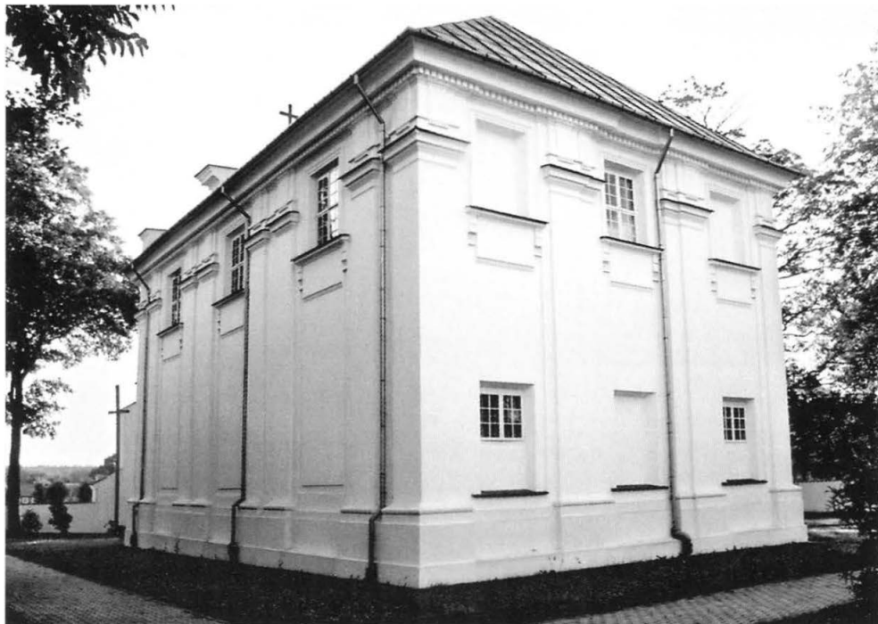
4. Elewacja tylna i boczna. Fot. D. Stankiewicz 2004. View of the back and side elevation. Photo: D. Stankiewicz 2004.
