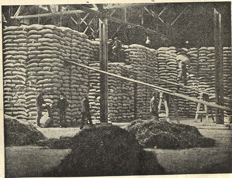
Port w Gdyni. Magazyn łuszczeni ryżu.
