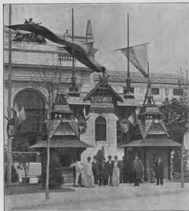
WYSTAWA TECHNICZNA WE LWOWIE. U wejścia.
