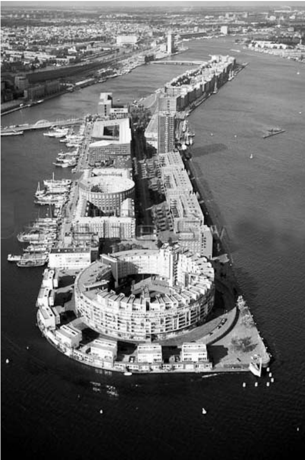
Ryc. 1. Widok zabudowy w Eastern Docklands w Amsterdamie; fot. Siebe Swart/Hollandse Hoogt
