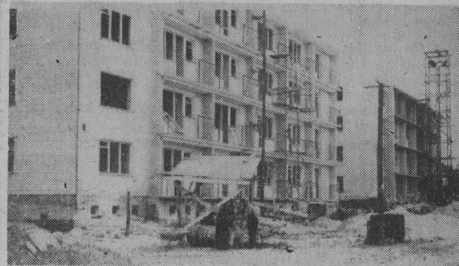
W Sokółce rozwija się budownictwo mieszkaniowe. Na zdjęciu budynki spółdzielni mieszkaniowej.
