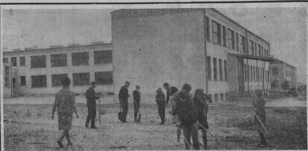
Ostatnie prace porządkowe przed otwarciem nowego Liceum Ogólnokształcącego w Mońkach. Fot. Z. Zaremba
