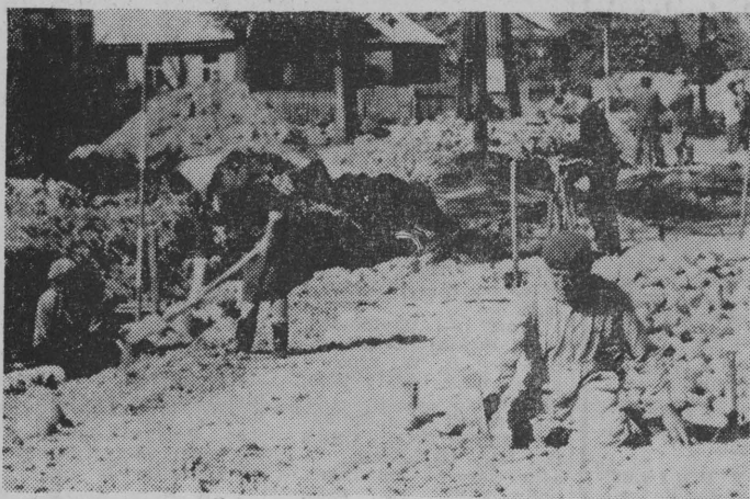
NA ZDJĘCIU: przebudowa ulicy.
