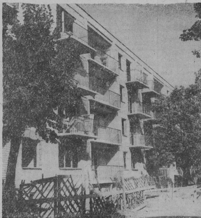
NA ZDJĘCIU: budowa nowego bloku mieszkalnego przy ulicy Kościuszki. Fot. Z. Z.
