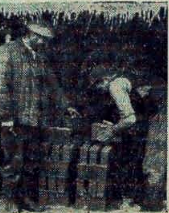
Mistrz cegielni Mątwa Jan Bartnicki instruuje Bronisława Koldysa przy układaniu cegły w suszarni.
